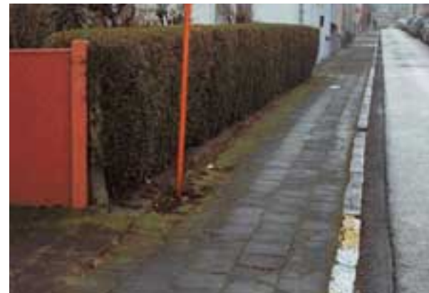
Foto 10. De voegen aan de voet van dit paaltje zijn slecht afdicht. Bovendien is er een verzakking. Dat zijn allebei omstandigheden die kruidgroei aantrekken.
