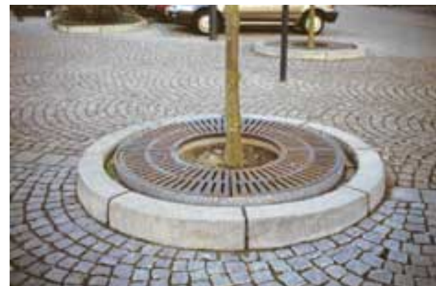
Foto 43. De bodem rond een boom kan kruidvrij worden gehouden en tegen betreding beschermd door een boomrooster.
